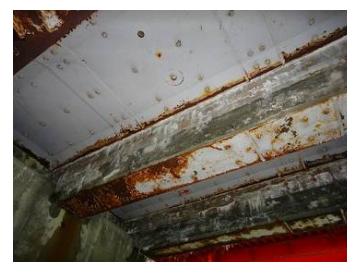
写真-2 第1径間の下面状況
