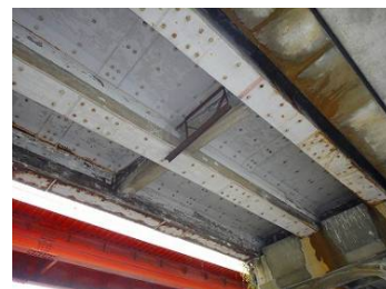
写真-1 第7径間の下面状況
