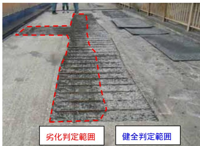
(図-2) 床版上面の劣化状況確認例
