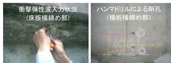
写真-2 調査状況
