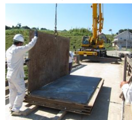
写真4 載荷試験状況
