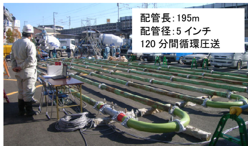
写真-1 ポンプ圧送試験状況
