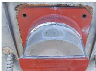
写真-3 接続具充填状況
