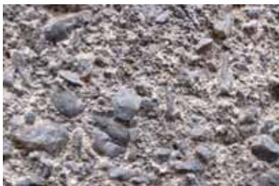
写真1 コンクリートの表面劣化
