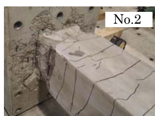
(乾式 PCM 吹付け補強)
