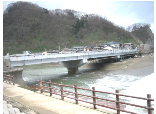
写真-1 塗膜を調査した橋梁
