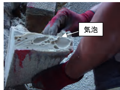
写真-3 樹脂注入断面
