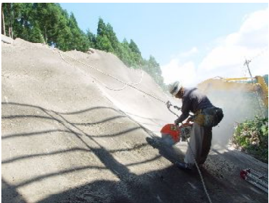
写真-1 人工クラック作製状況
