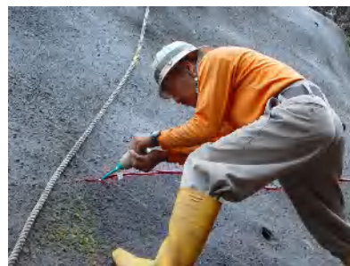
写真-2 樹脂注入状況
