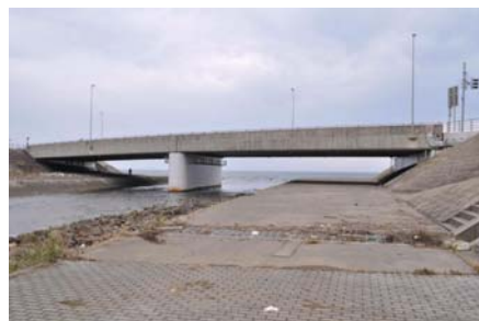
写真-1 名立大橋全景
