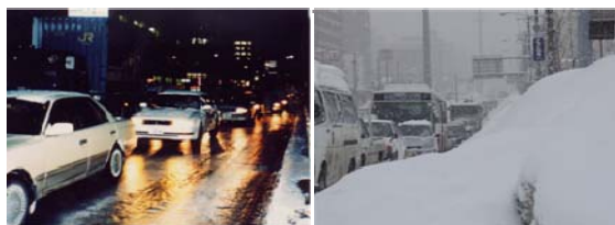
写真-1 冬期道路の状況 (左：凍結路面 右：路肩堆雪)
