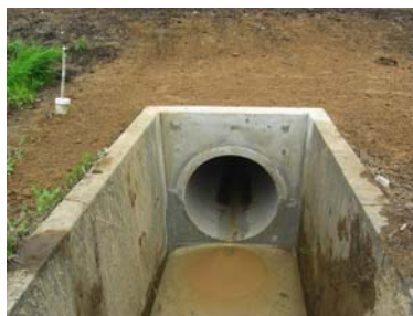
施工後（下流側）
