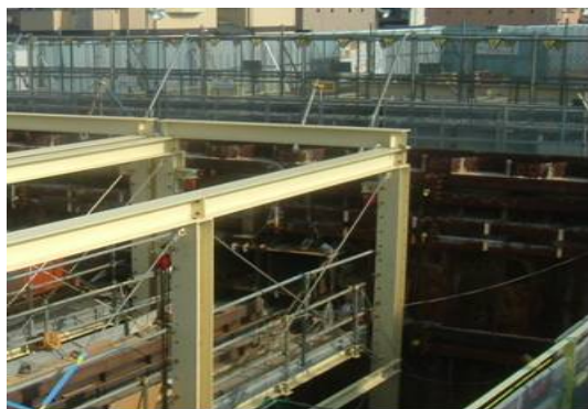
写真-1 鋼製函体牽引状況
