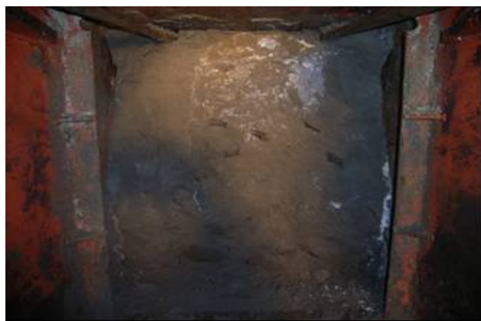
写真-2 帯水層の掘削状況
