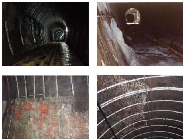
図1 レンガトンネルの変状
