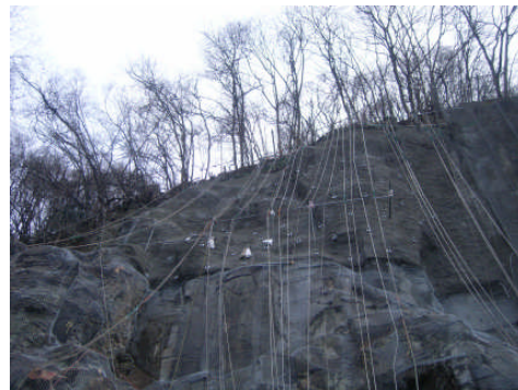
写真4 ロックボルト施工写真
