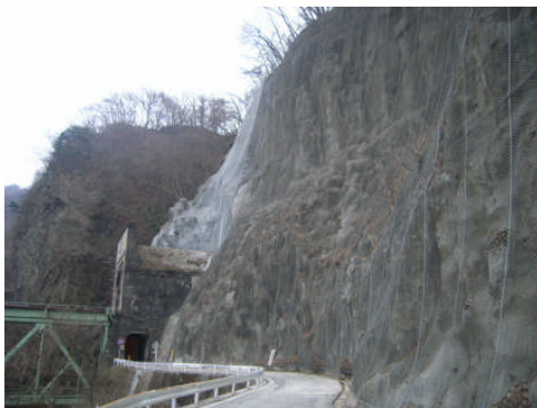
写真5 工事完了状況
