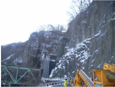
写真1 施工箇所の全体風景
