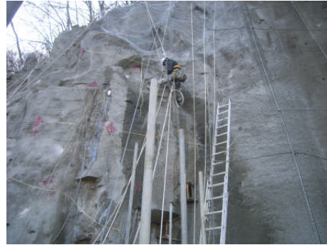
写真2 ボンドによる接着工程
