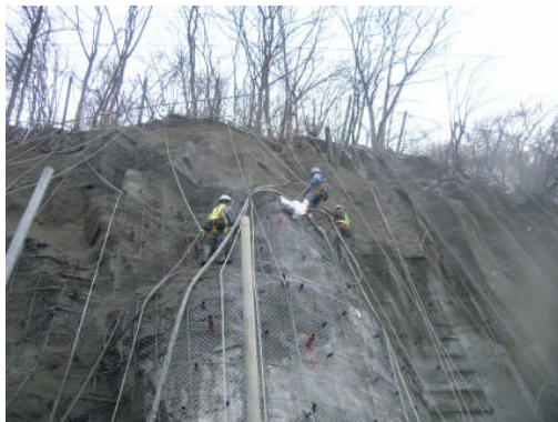
写真3 コンクリート吹き付け状況
