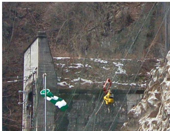
写真2 トンネル坑口に設置されたシェルターの状況
