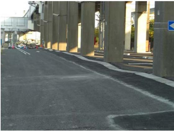
写真-2 舞浜駅構内の液状化による舗装の不陸
