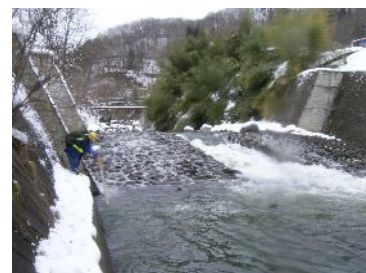
写真-5 堰堤の設置
