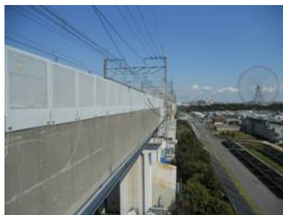
写真-3 防風柵設置状況
