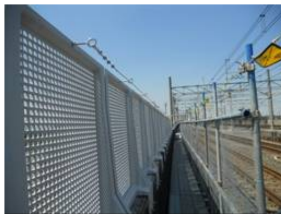
写真-2 落下防止ワイヤー取付状況
