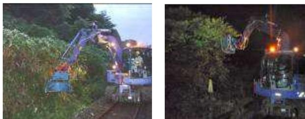
図-6 施工基面の除草 図-7 雑木の伐採
