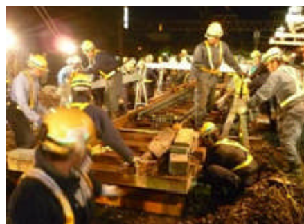
図-8 新分岐器挿入
