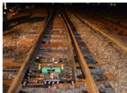
図-9 分岐器弾性化施工後
