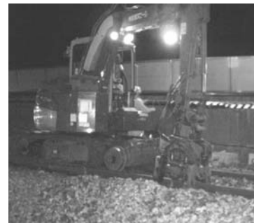
図2 BHTTによるつき固め
