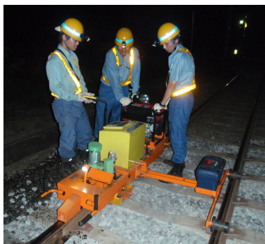
図-3 一頭式レール削正機
