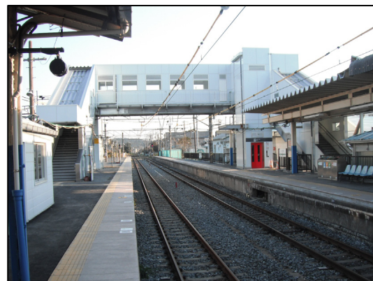
写真-2 施工完了
