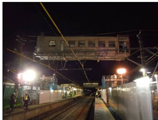
写真-1 クレーン架設状況
