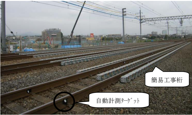
図-3 簡易工事桁設置状況
