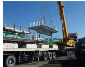
写真-4 横梁・スラブ部材建込み
