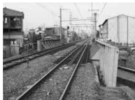
写真1 橋りょう全景
