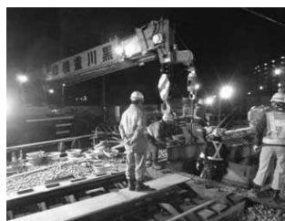
写真 2 橋りょう撤去状況
