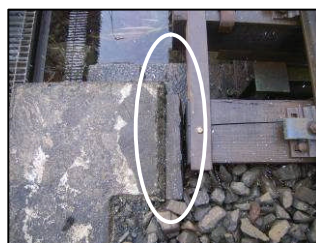
①バラスト止め材とマクラギに隙間がない場合
