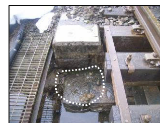
②バラスト止めとマクラギに隙間がある場合
