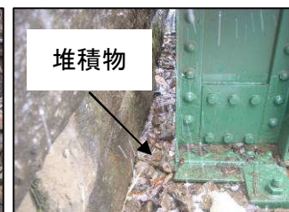
②バラスト止めが施工基面より低い場合
