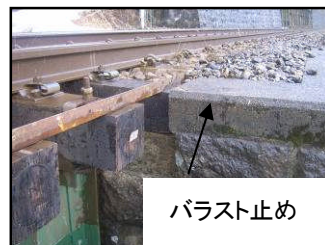
①バラスト止めが施工基面と同レベルの場合
