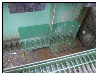
①バラスト止めが施工基面と同レベルの場合
