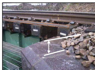
②バラスト止めが施工基面より低い場合
