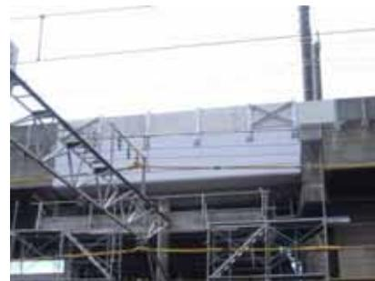
図1 補強後の調整桁(仮設足場撤去前)
