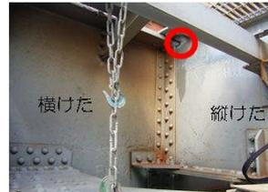
写真-2 縦横桁連結部
