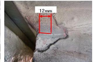
写真-3 縦桁端部首溶接部亀裂
