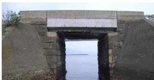
写真-1 当該橋りょう(線路左側より)
