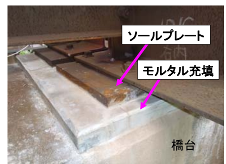
図10 補修後の状況
