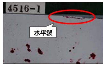
図-3 浸透探傷検査
