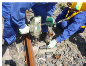
図-4 埋込栓削孔清掃状況
