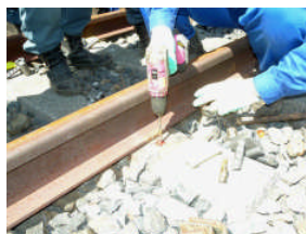
図-6 ケミカルアンカーカプセル樹脂攪拌孔内の清掃を実施する。
