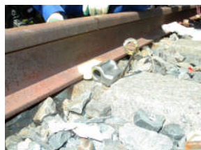
図-7 硬化養生状況
