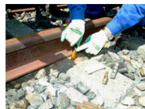
図-5 カプセル樹脂挿入状況
