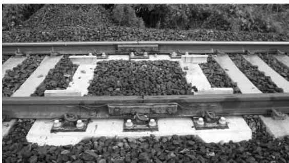
図-1 従来のグリッドマクラギの例
