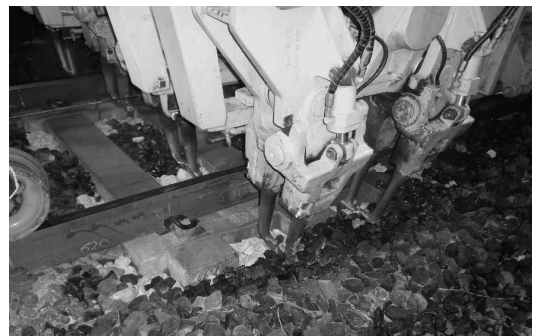
図-6 グリッドマクラギ部のMTTつき固め
