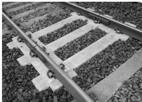
図-4 試験敷設したグリッドマクラギ
