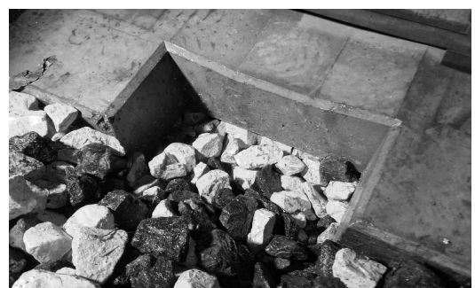
図-7 MTTによる砕石かき込み状態の確認
