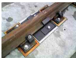
図-1 レール転倒防止装置
