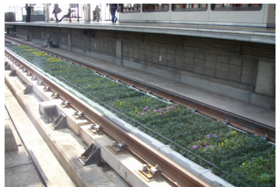
写真-3 植栽パレット設置後ラダー軌道
