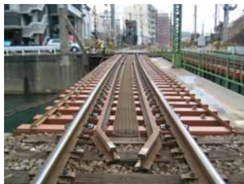
写真1 現地写真（起点より）
