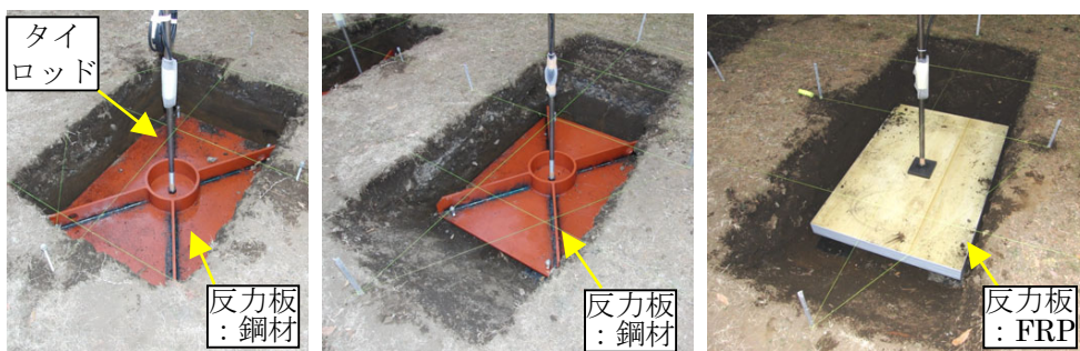
図2 反力板およびタイロッドの設置状況
