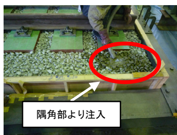
図 4 グラウト材のてん充状況①
