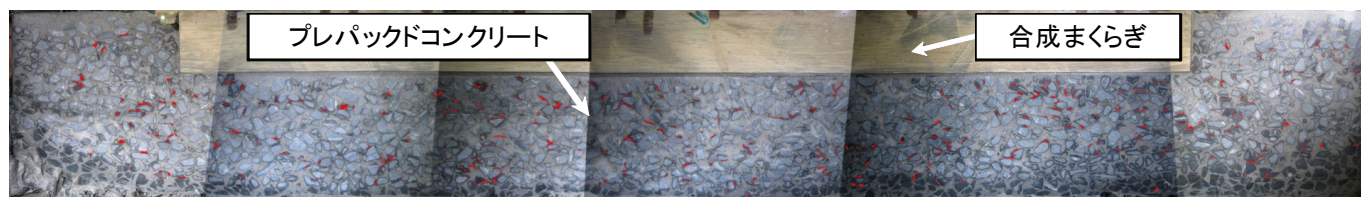
図10 道床の切断面
