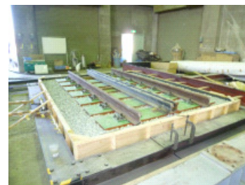
図 3 軌きょうの設置状況
