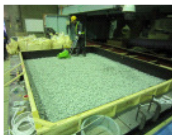
図 2 単粒度碎石 3 号の締固め状況
