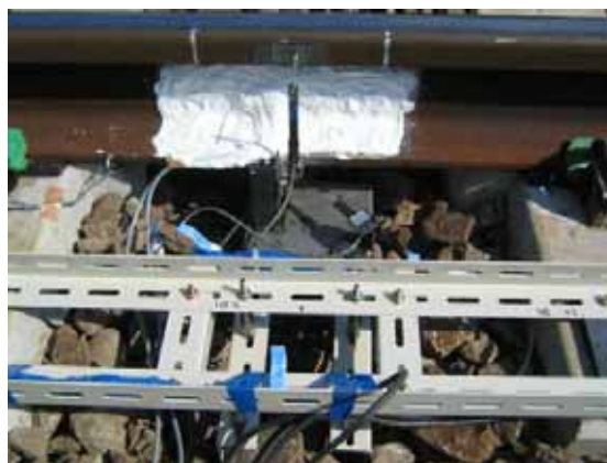
写真 - 3 試験機器設置状況
