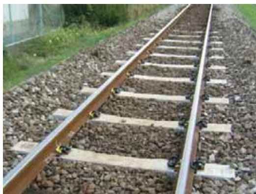
写真 - 1 まくらぎ敷設方法
