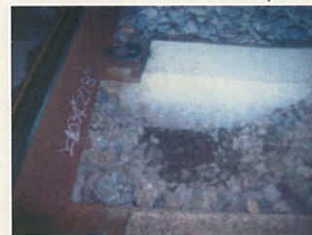
図3 道床状態(細粒化)
