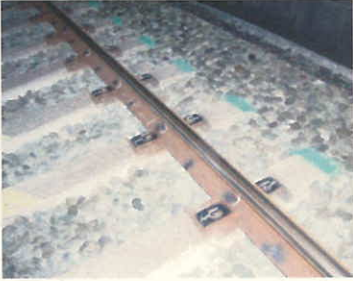
図9 対策工の施工後全景
