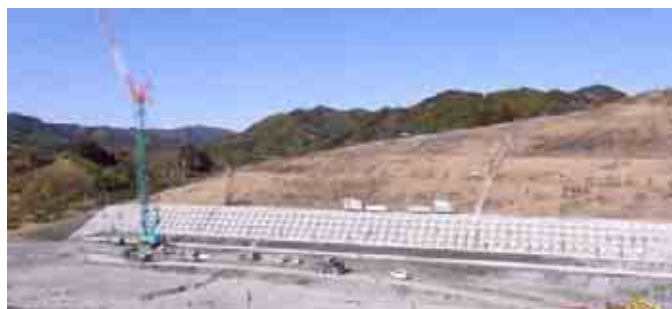
写真-1 グラウンドアンカー工完成状況
