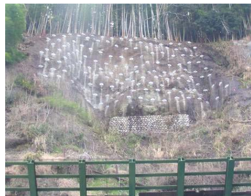
写真-5 施工完了全景
