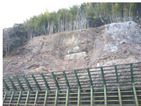
写真－2 線路からの状況
