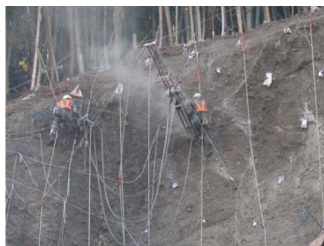
写真-4 施工状況
