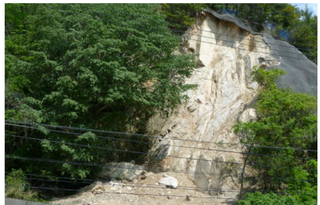
写真1 坂町小屋浦地区災害状況
