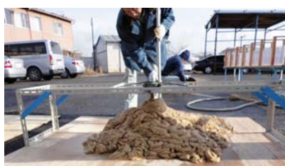
(c) 打設完了状況
