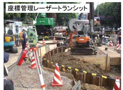
写真2 打設精度管理
