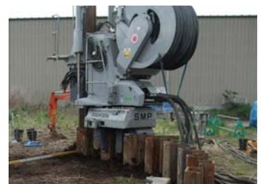
写真1 鋼矢板の円形打設
