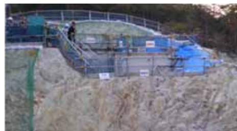
写真-1 試験杭載荷試験
