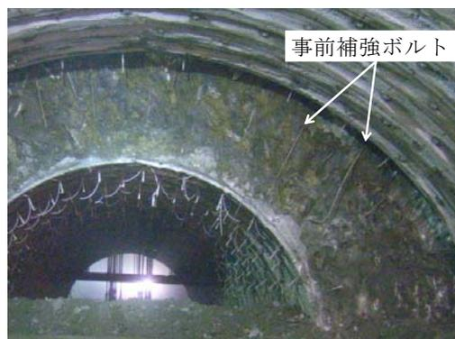
図7 掘削時の切羽状況
