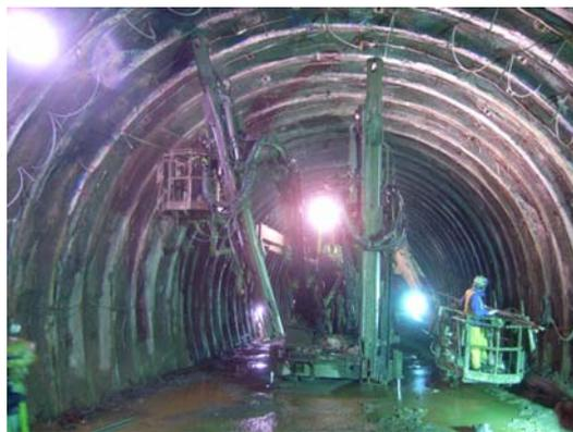
図5 事前補強ボルト施工状況
